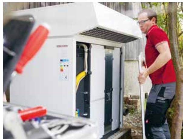
16 | Austausch einer Wärmepumpe
