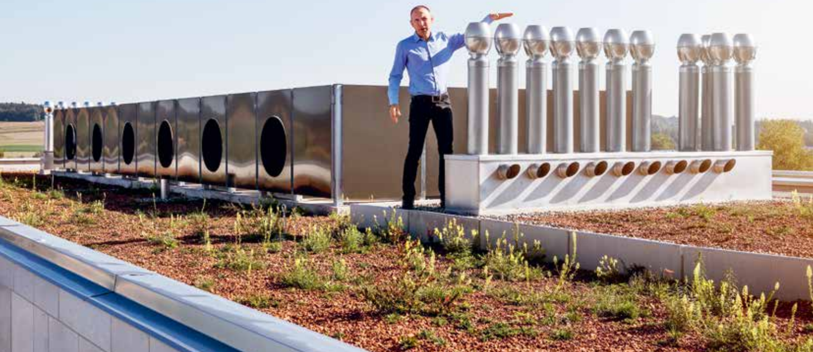
Kaskaden sind in Serie geschaltete Einzelwärmepumpen.
