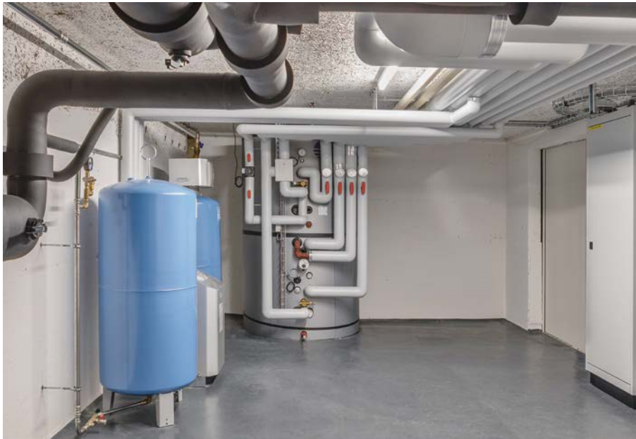
Hygienisch einwandfreies Frischwasser mit dem Hygienespeicher HS-BM 1760 L
