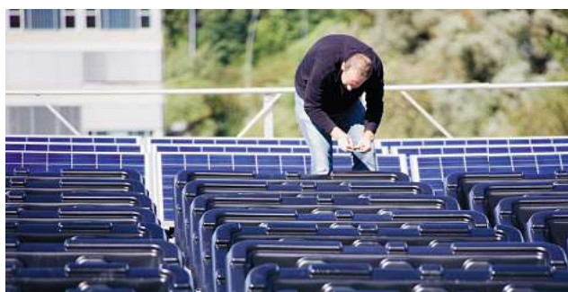
Placement des modules sur le toit
