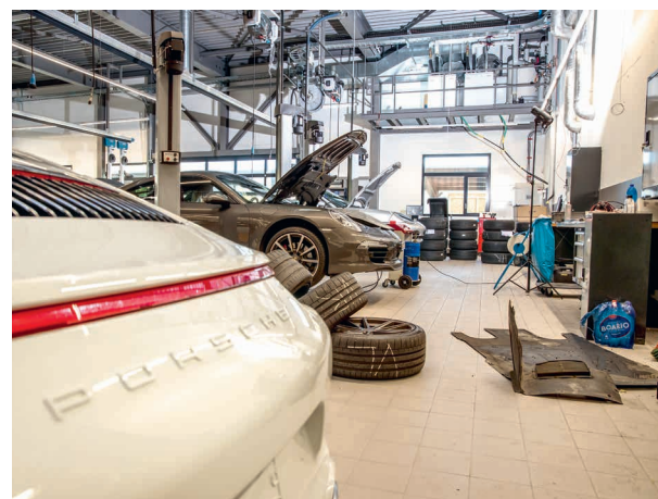
12 | Une pompe à chaleur dans un endroit insolite
