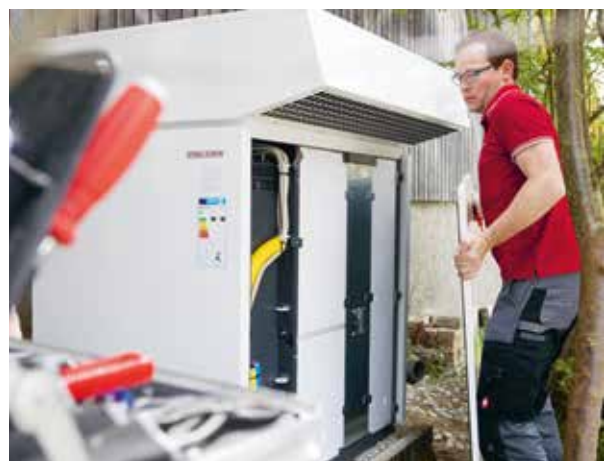
16 | Remplacement d'une pompe à chaleur
