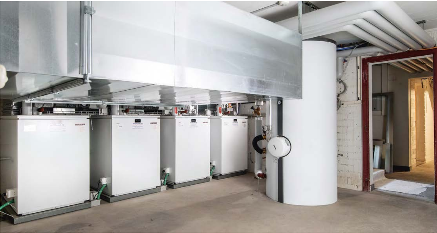
Cascade de 4 unités avec un guidage d'air spécialement adapté.
