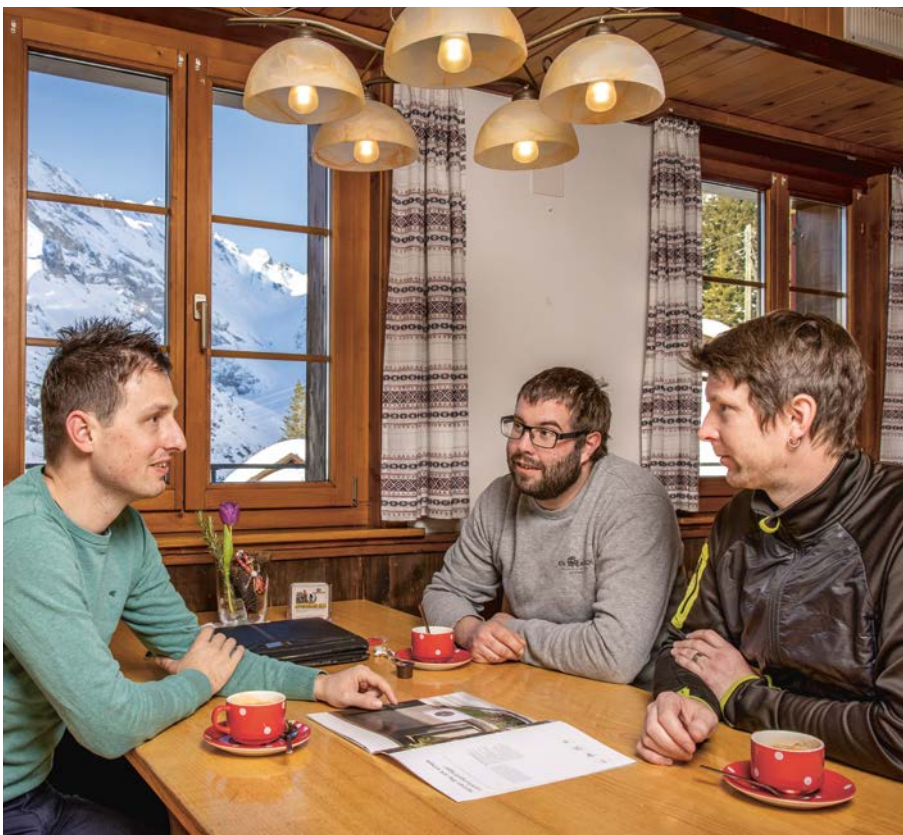
Une chaleur agréable dans le restaurant grâce à une cascade de trois pompes à chaleur air-eau.
