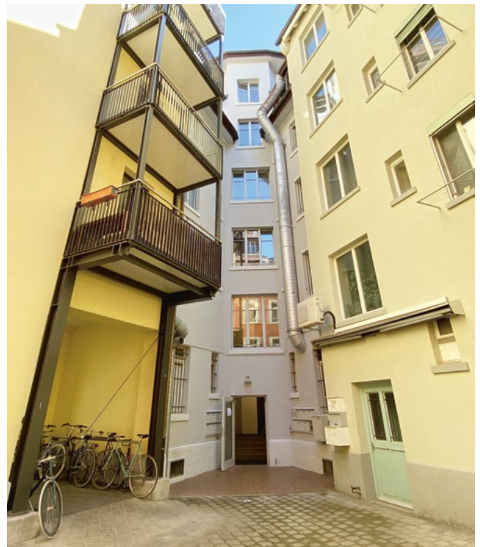
La cour intérieure n'est pas adaptée à l'installation de pompes à chaleur
