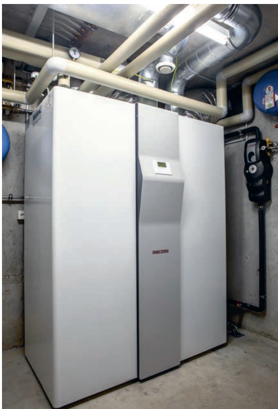
L'unité de ventilation intégrale compacte LWZ 8 CSE Premium
