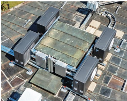
L'installazione sulla struttura dell'ascensore sul tetto
