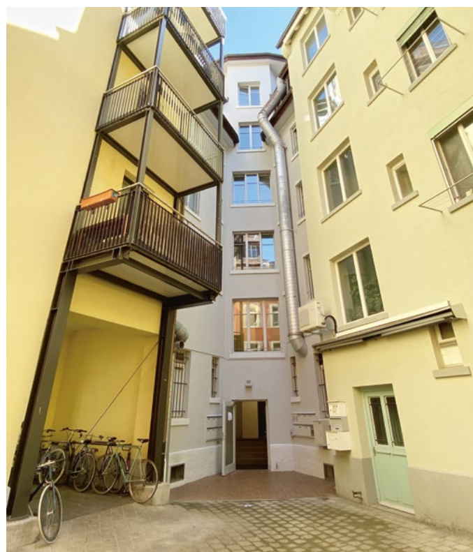
Il cortile non è adatto per l'installazione di pompe di calore
