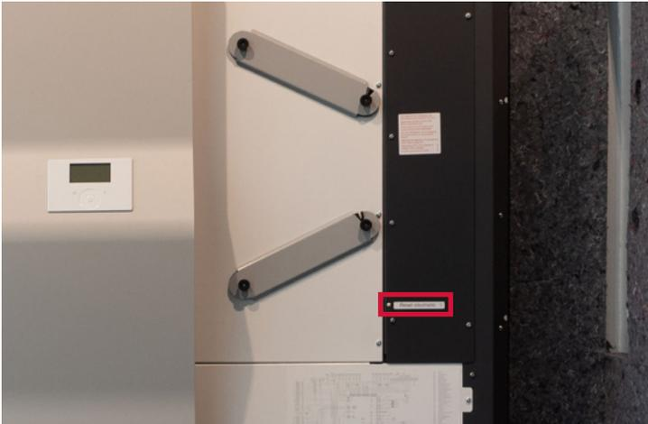
3. Das Gerät mit geöffneter rechter Seite sieht so aus. Den Reset-Button sehen Sie unten angezeichnet.
