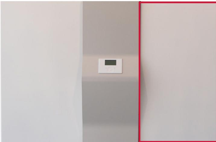
1. Öffnen Sie mittels Knopf die rechte Seite der LWZ-Wärmepumpe.
