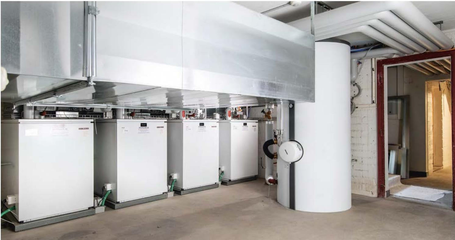
4er-Kaskade mit speziell angepasster Luftführung.
