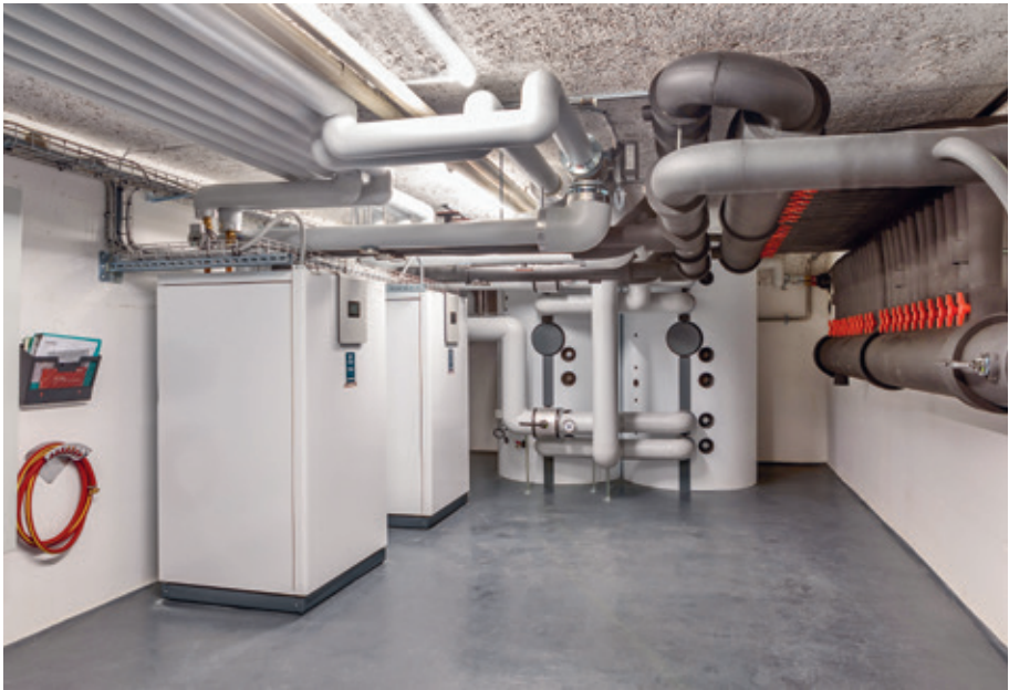
Kaskade aus 2 Erdsonde-Wärmepumpen WPE-I H Premium mit Inverterregelung
