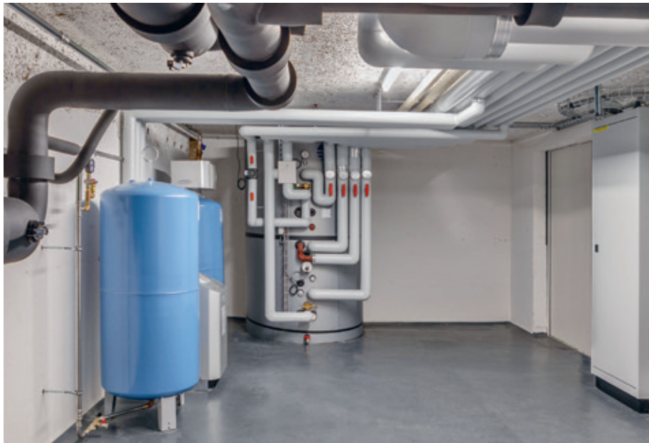
Hygienisch einwandfreies Frischwasser mit dem Hygienespeicher HS-BM 1760 L
