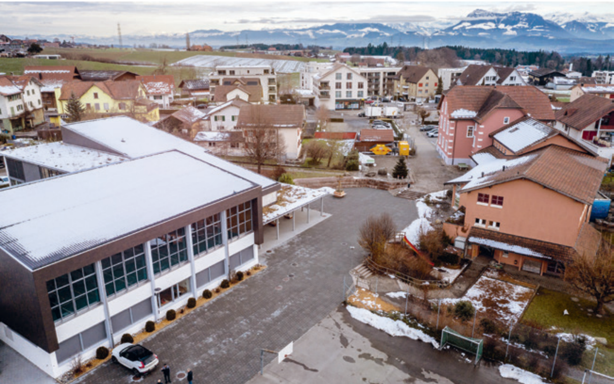
Gelungene Heizungs- sanierung: Die Schul- anlage in Hildisrieden heizt nun mit erneuer- baren Energien.
