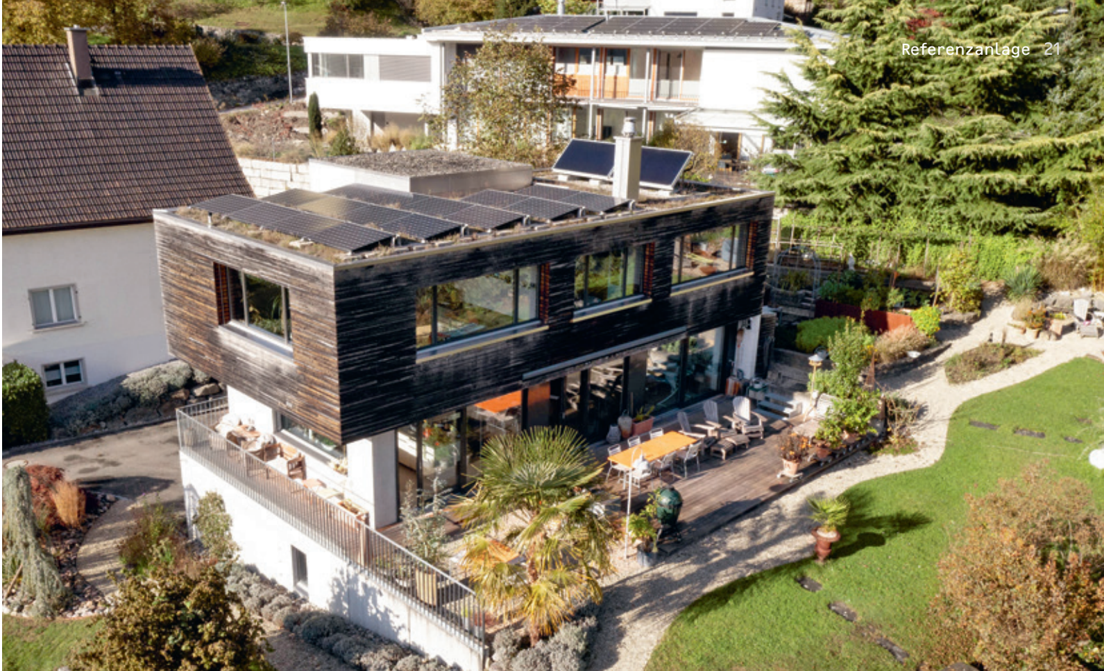
Die installierten Photovoltaikmodule versorgen das Gebäude mit selbstproduziertem Strom und Solarmodule unterstützen die Wärmerückgewinnung
