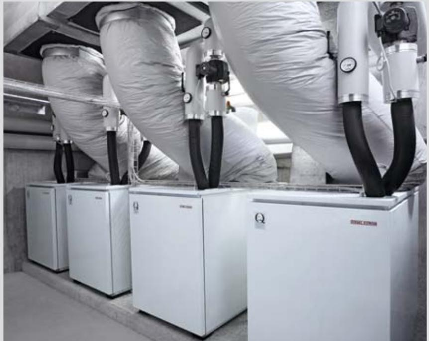
Die WPL kann als Einzelgerät oder in einer Kaskadenschaltung genutzt werden. Ideal ist sie für niedrige Vorlauftemperaturen wie bei einer Fussboden- oder Niedertemperaturheizung.
