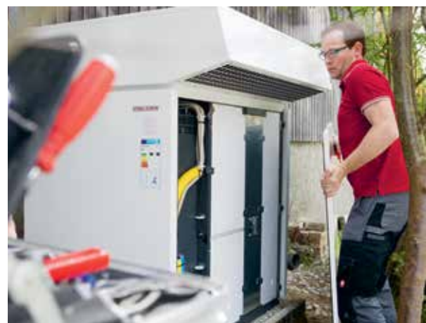
16 | Remplacement d'une pompe à chaleur
