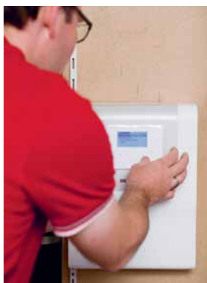
Le réglage de la courbe de chauffe fait également partie de la mise en service.
