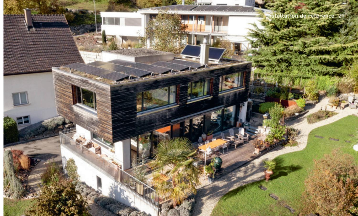
Les modules photovoltaïques installés alimentent l'appareil en électricité autoproduite et les modules solaires contribuent à la production de chaleur
