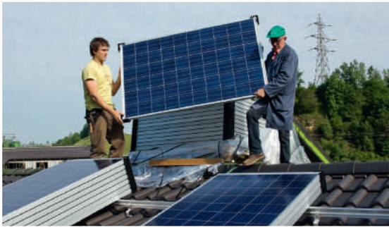
17 | Placement des modules sur le toit
