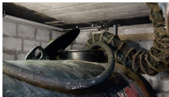
2 | Nettoyage de la cuve à mazout et pompage du mazout résiduel
