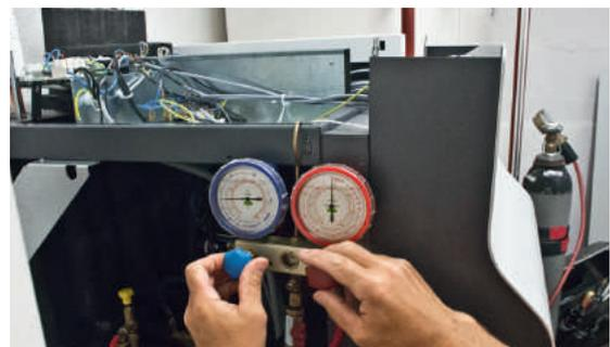
14 | Remplissage et mise sous vide des conduites de fluide frigorigène (contrôle d'étanchéité)
