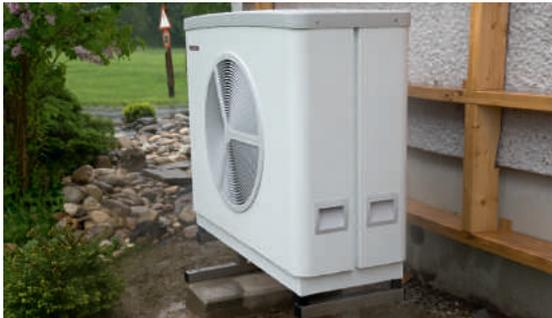
9 | Unité extérieure montée sur socle en béton
