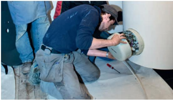
7 | Raccordement électrique du préparateur d'eau chaude
