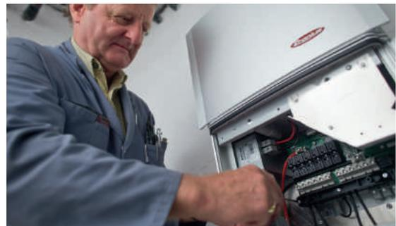
20 | Raccordement électrique à l'onduleur
