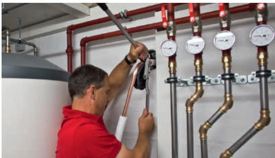
11 | Mise en place de la conduite de fluide frigorigène
