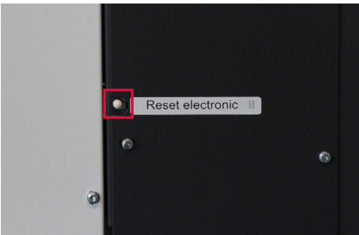
4. Premere il pulsante di reset per tre secondi. La pompa di calore viene ora riavviata.
