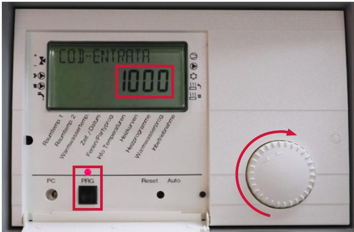
3. Sul display compare «0000» con il primo «0» che lampeggia. Ruotare ora la manopola verso destra finché nella prima posizione appare un «1» che lampeggia (codice 1000). Premere infine quattro volte il pulsante PRG.
