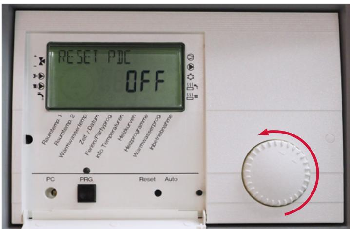
5. Ruotare la manopola verso sinistra finché compare il testo «RESET PDC OFF».
