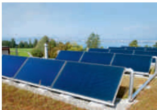
L'impianto solare autonomo copre circa il 40% del consumo per riscaldamento ed acqua sanitaria.
