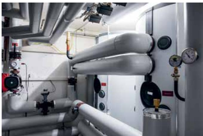
I serbatoi tampone forniscono acqua calda per il riscaldamento.
