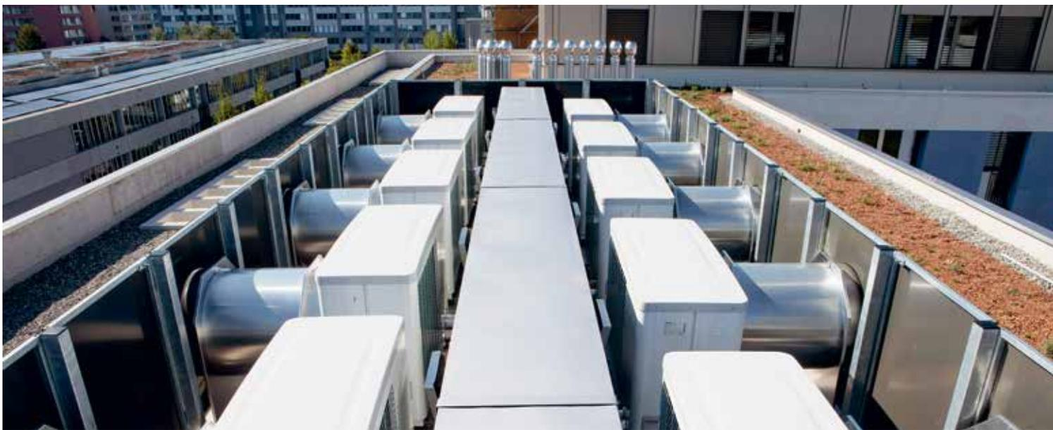
Gli impianti con collegamento in cascata si dimostrano più facili da montare, più flessibili e più ergonomici rispetto ai grandi apparecchi e sono migliori delle grandi pompe di calore anche nella tecnica acustica.
