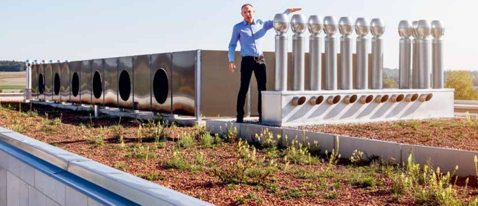
Le cascate sono costituite da pompe di calore singole collegate in serie.
