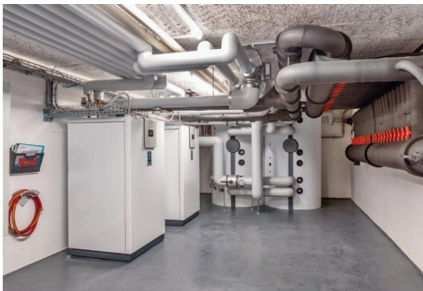
Cascata composta da 2 pompe di calore con sonda geotermica WPE-I H Premium con regolazione mediante Inverter
